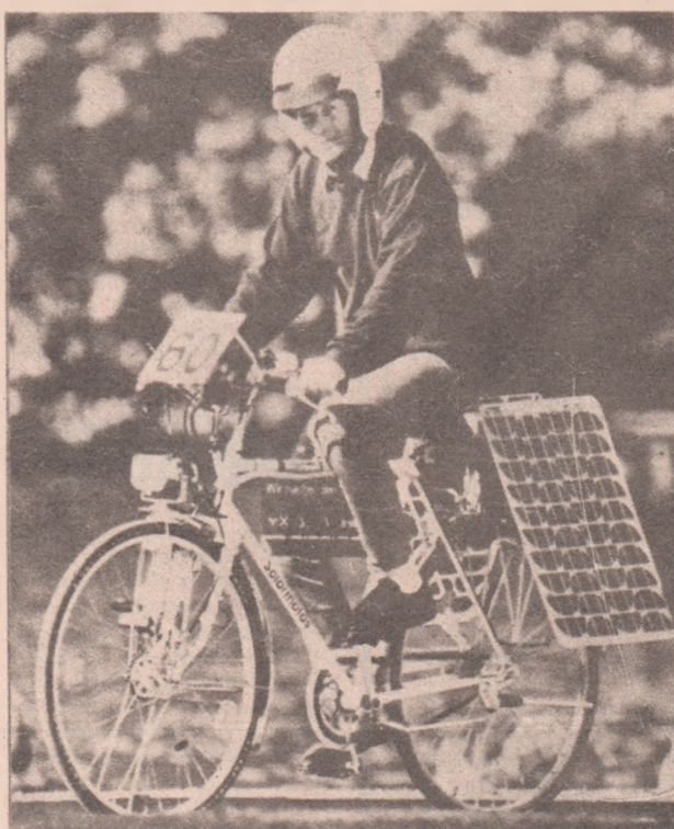
ФРГ. Солнечные батареи как источник питания транспортного средства завоевывают все больше поклонников в среде автомобилистов. Кажется, впервые эта идея пришла по душе двум велосипедистам из Килля. Юрген Браммер (на снимке) и его товарищ по университету Пауль Кунштманн приспособили к обычному велосипеду солнечные батареи, которые подружились к легкому моторчику. В ясный день солнечный велосипед способен развивать скорость до 45 километров в час, а если солнце зайдет, то на запасенной энергии можно проехать, не нажимая на педали, три часа. (ТАСС).
